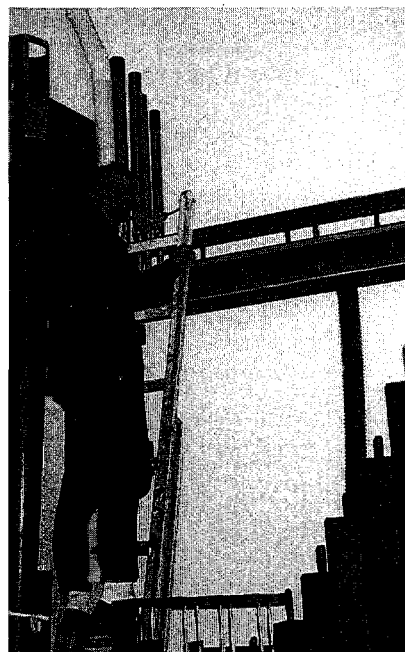
Dale installing the Plein Jeu III pipes
